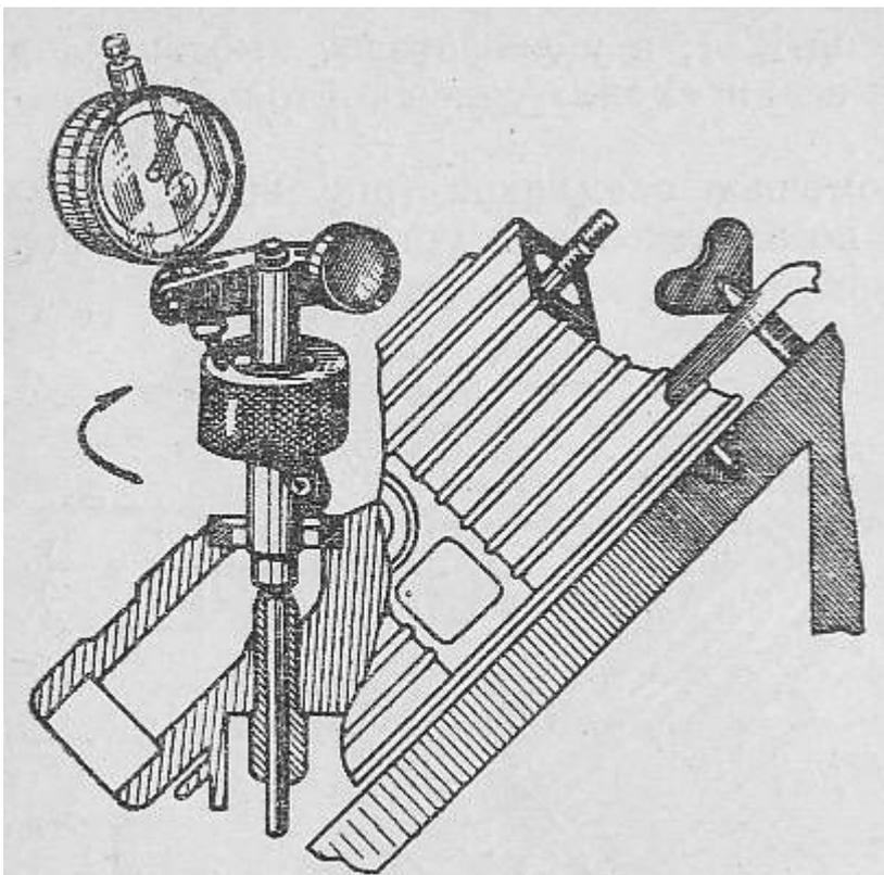
*Р и с. 29. Приспособление для проверки концент-
